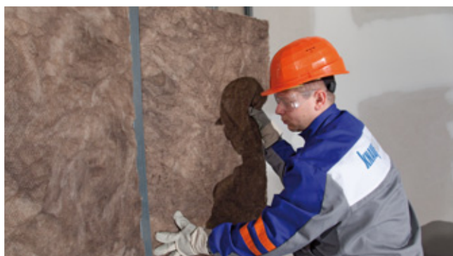
Aplikace minerální izolace do připraveného roštu, vložení lehkým stlačením
