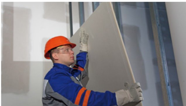
Instalace sádkartonových desek na připravený rošt
