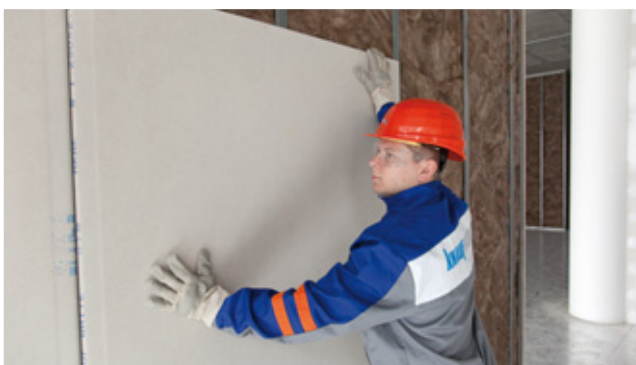
Instalace první vrstvy sádkartonových desek na připravený rošt
