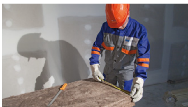
Odměření předem stanovené části minerální izolace, standardní rozteč je 625 mm
