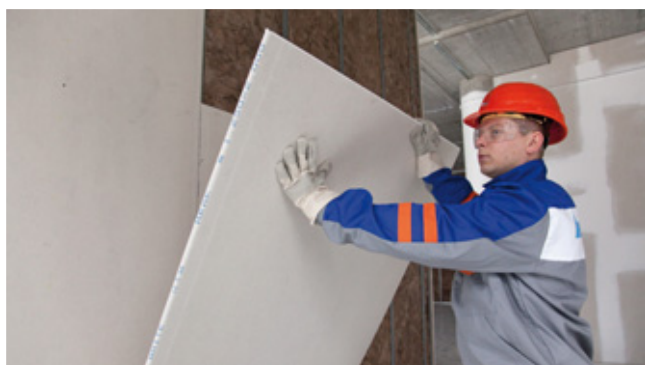
Instalace druhé vrstvy sádkartonových desek na připravený rošt, druhá vrstva musí překrývat napojení desek první vrstvy
