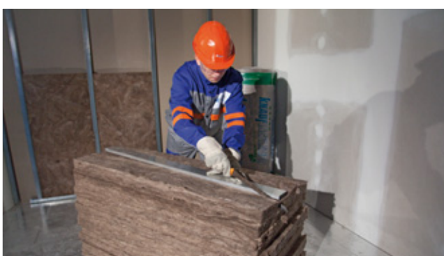
Odříznutí předem stanovené části minerální izolace pro nestandardní rozteč
